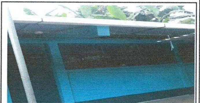
Foto 6: Sustitucion de canal de pvc.
