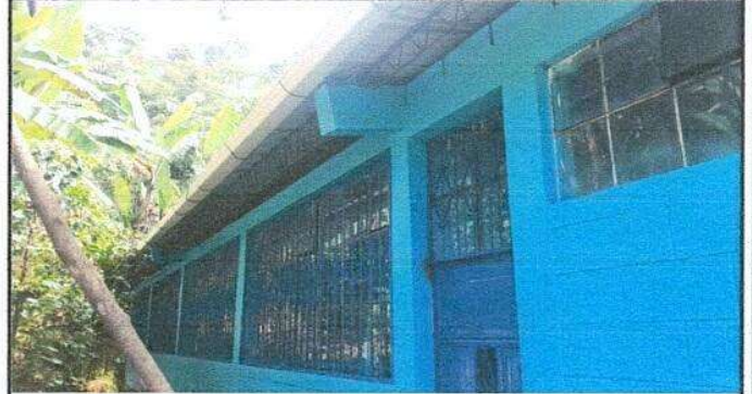
Foto 2: Sustitución de balcones de metal.
