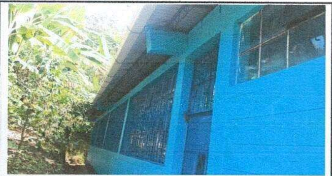
Foto 5: Sustitución de canal de pvc.
