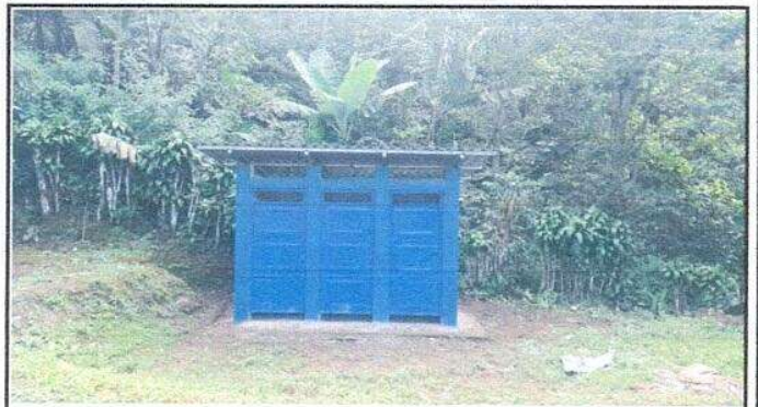
Foto 4: Sustitucion de puerta de baño.
